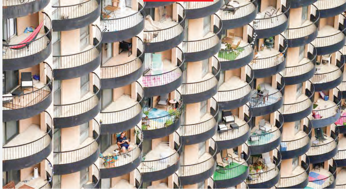
بالکن های یک مجتمع مسکونی در شهر آریلنگتون ایالت ویرجینیا آمریکا.
